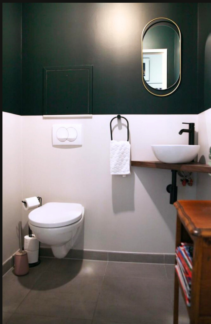
Rénovation et aménagement d'un espace toilettes.
