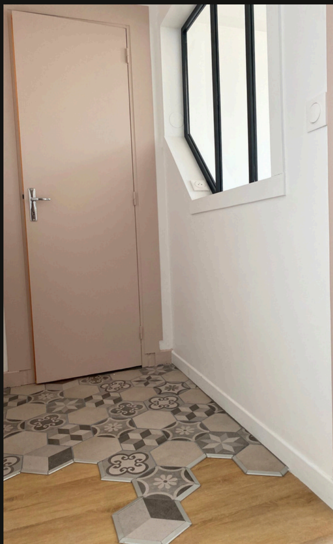
Rénovation générale d'un bureau : Parquet avec carrelage incrusté, verrière sur-mesure et mise en peinture.
