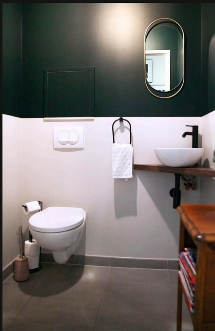
Rénovation et aménagement d'un espace toilettes.
